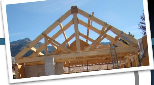
La poutre au vent évite que la partie supérieure du long pan et du pignon rentrent en flexion. Ce phénomène n'est pas simulable sur la maquette car les baguettes sont trop rigides.
