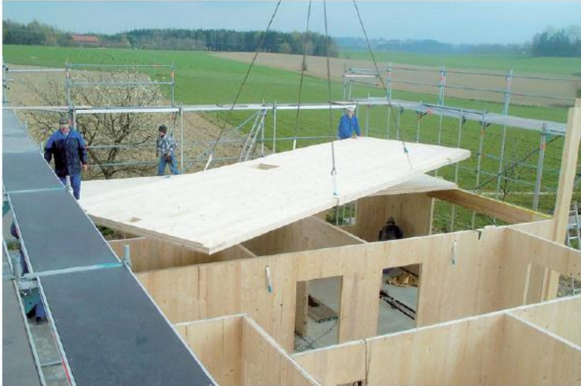
**Principe** : Structure porteuse constituée de panneaux massifs nommés CLT (cross laminated timber). Ils sont préfabriqués à partir de plusieurs couches de planches (toujours un nombre impair) croisées à 90 degrés et collées ou cloués entre elles..
