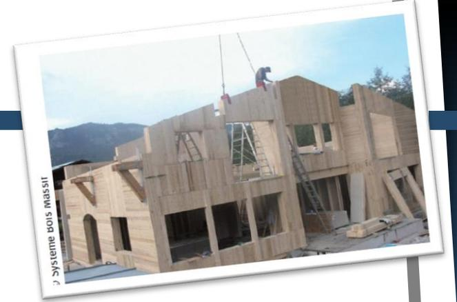
**Principe :** Structure porteuse constituée de poteaux verticaux et de poutres horizontales ou inclinées, disposés à intervalles réguliers, libérant de grands volumes. Remplissage des cavités par éléments opaques ou translucides..
