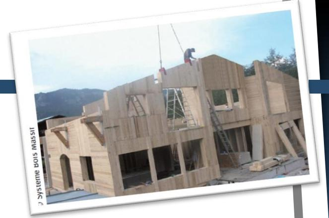
**Principe :** Sciages de grande longueur cloués pour former un ensemble de cadres avec un faible écartement, contreventés (ou stabilisé) par un panneau bois.
