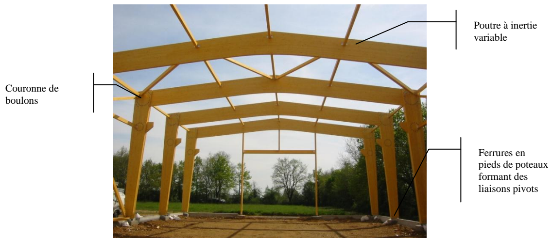
Figure B61 : Exemple de portique hyperstatique (@ Charpentes Fournier)
