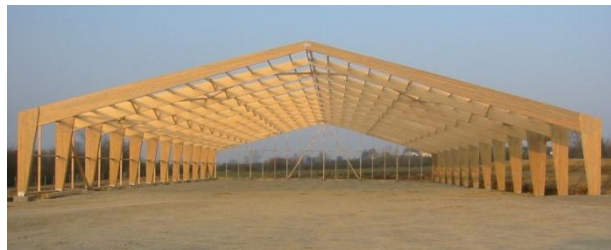
Figure B59 : Exemple de portique statique (Charpente Fournier 3 @ Charpentes Fournier)
