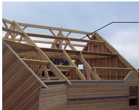
Figure B52 : Exemple d'élément sur trois appuis (@ MBC (Maison Bois Cruard))
