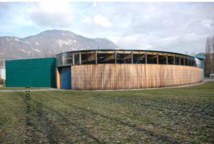
▲ Le grand volume courbe de la remise est revêtu d'un bardage en mélèze surmonté d'un haut bandeau vitré continu.
