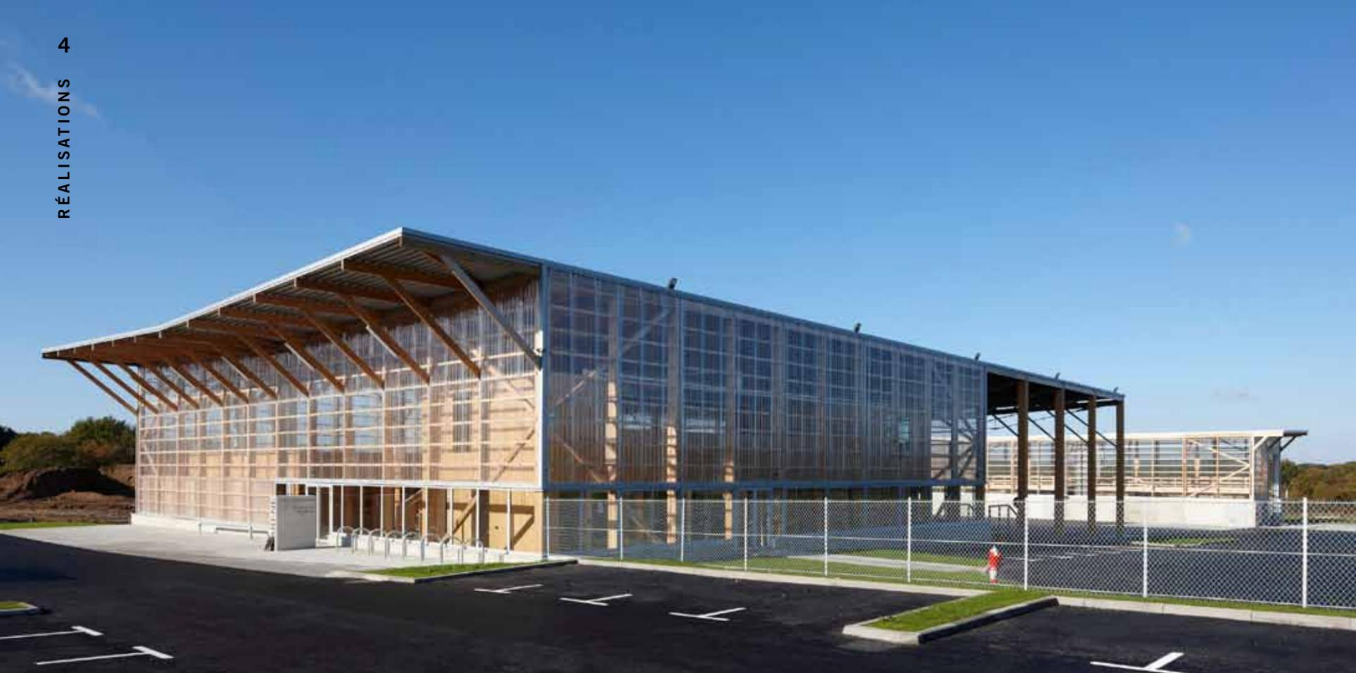
◀ Le principe constructif du centre d'exploitation consiste à mettre à l'abri des intempéries les structures bois de l'édifice derrière une vêtue en polycarbonate transparent.
