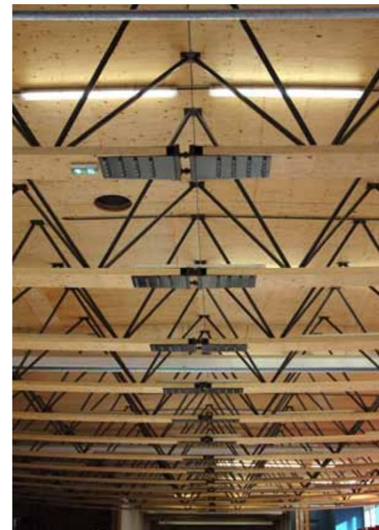
▲ Les poutres préfabriquées en deux parties sont assemblées sur site au moyen d'une platine centrale métallique.
