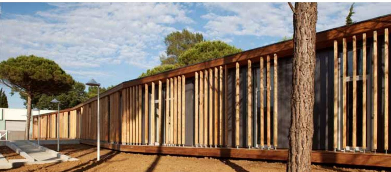
assure ainsi sa protection solaire. De larges ouvertures créent un lien direct entre l'intérieur et l'extérieur pour profiter de vues agréables sur l'environnement. Les montants verticaux en bois dont l'espacement variable est très précisément dessiné se détachent sur le fond sombre du bardage métallique qui revêt la façade. Ce dispositif renforce la continuité visuelle et spatiale de l'édifice tout en répondant aux contraintes climatiques locales.
