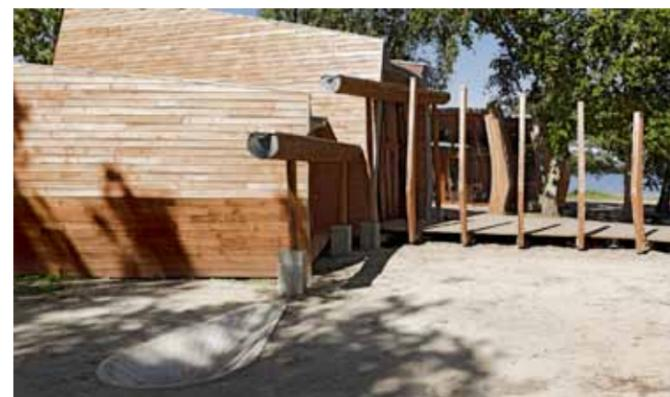
▲ Des demi-troncs de pin font office de chéneaux de récupération des eaux pluviales en bout de bâtiment.
