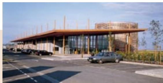
① Sous un vaste toit à structure en bois lamellé-collé prennent place tous les services de l'aire de repos.
