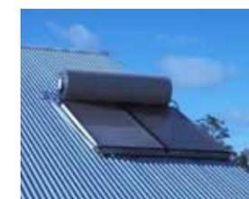
Il existe différentes technologies de chauffe-eau solaire : auto-stockeur, à éléments séparés et monobloc. Ce dernier étant le plus courant en Guyane.
