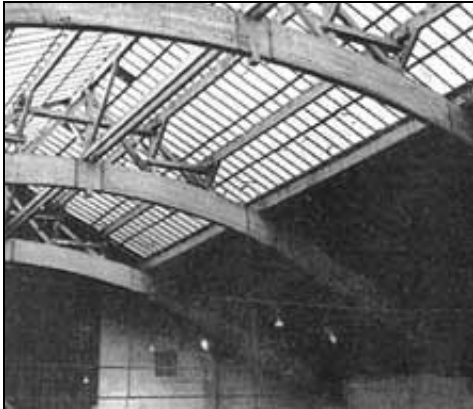
Garage construit avec le système Hetzer Paris 1937
