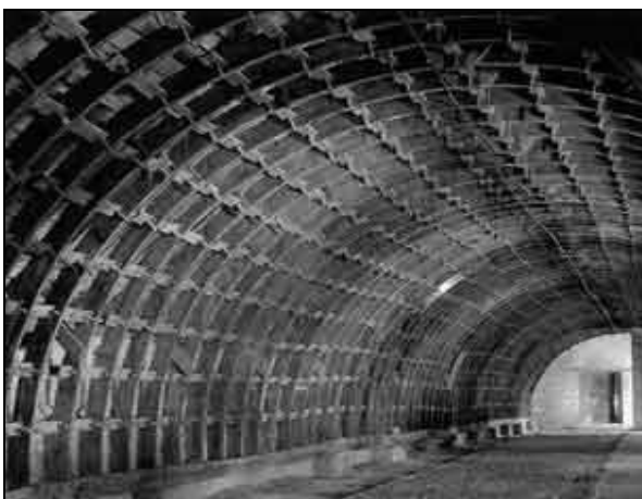
Charpente de la Caserne Rochambeau Mont-Dauphin, Hautes Alpes (1823)
