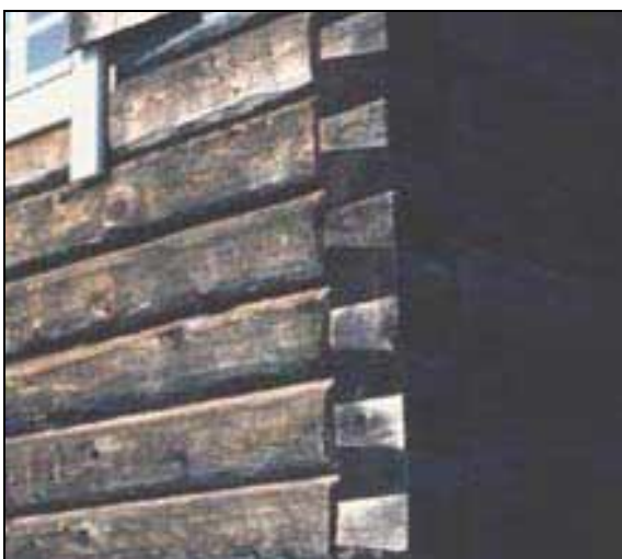
Pièces équarries assemblées par queues d'aronde
