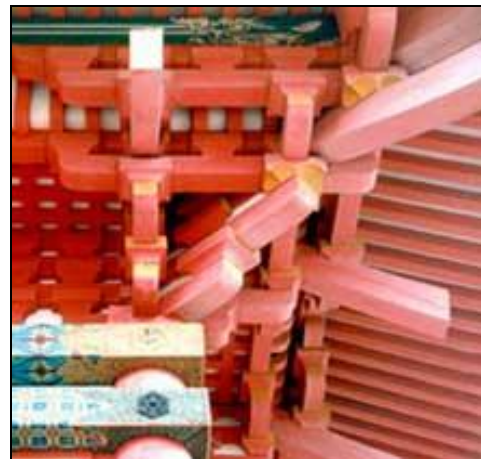
Temple de Kyomizu à Kyoto (Japon) Détail de la console
